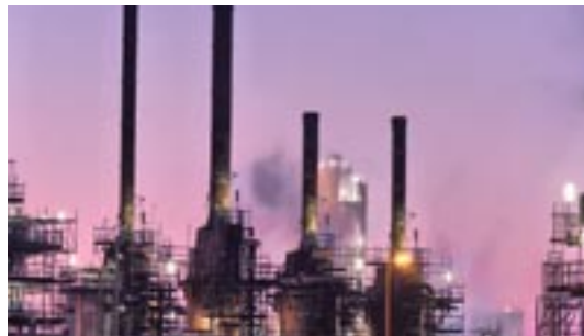
Maintenance générale ateliers de mécanique entretien
